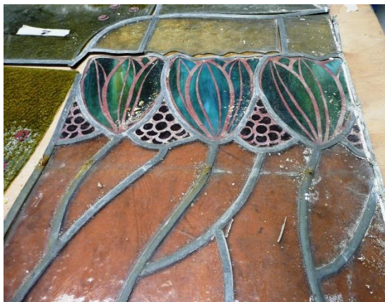
In het kader van vooronderzoek een uitgenomen compleet glas-in-loodpaneel. Na voorzichtige ontmanteling wordt de staat van het loodskelet en de dichting tussen glas en lood gezien.
