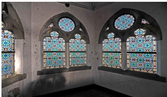
Vensters in een trappenhuis uit circa 1900. Per venster is er een indeling met middenmontant en daarboven een tracering in de spitsbogige raamkop.
